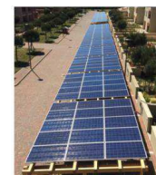
L'IMPIANTO FOTOVOLTAICO RIENTRA NELL'AMBITO DEL PROGETTO MARE GESTITO DA PFF GROUP LA CASA DELLE NUOVE ENERGIE DI FERRARA CHE PREVEDE INTERVENTI DI RIQUALIFICAZIONE ENERGETICA IN CAMPEGGI, STRUTTURE BALNEARI, RISTORANTI E ALBERGHI
