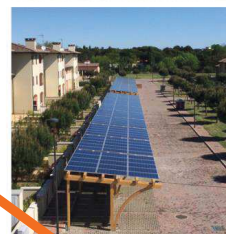
LE STRUTTURE RICETTIVE E RICREATIVE DEL VILLAGGIO AIRONE BIANCO SONO COLLEGATE A UN INVERTER POWER ONE PER UNA PRODUZIONE STABILITA DI 110 KW/ANNO
